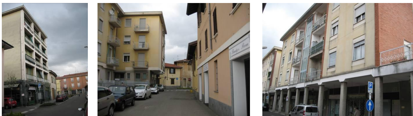
Figura 9 edifici di epoca recente nel centro storico di Rescaldina
